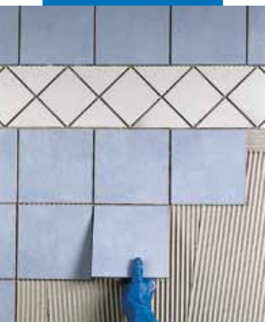
Ansetzen von Fliesen auf Gipskarton
