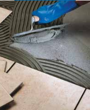
Fliesenverlegung mit Adesilex P9
