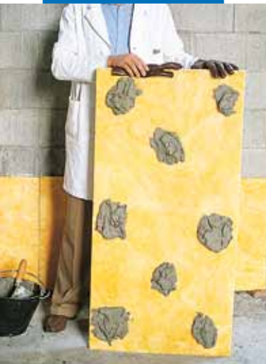
Punktklebung von Dämmplatten auf Mauerwerk
