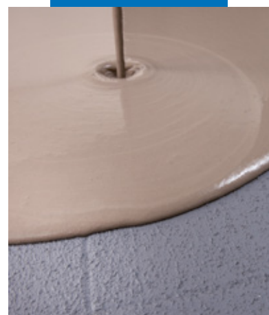
Auftragen von Ultraplan auf getrocknetem Eco Prim Grip
