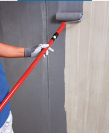
Aufrollen von Eco Prim Grip auf Beton
