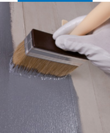
Aufstreichen von Eco Prim Grip auf Beton
