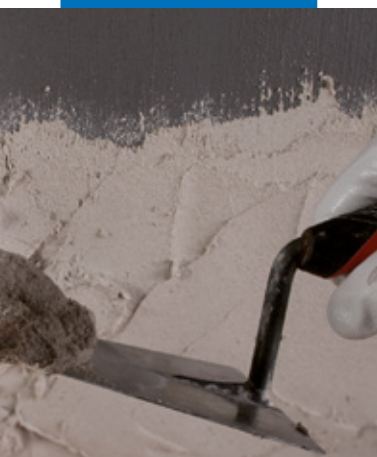
Aufbringen eines Putzes auf Eco Prim Grip
