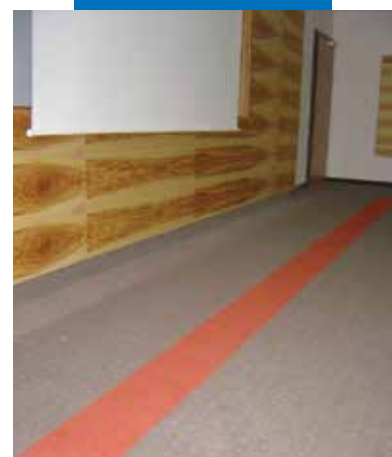
Anwendungsbeispiel für Primer G vor der Spachtelung mit Ultraplan Eco und der Verlegung textiler Beläge mit Rollicoll im Hotel Villa Castellani - Österreich
