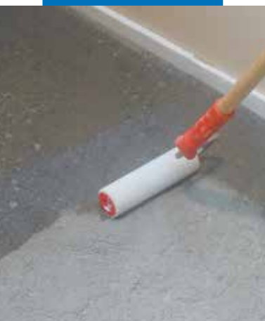
Auftragen von Primer G mit der Rolle
