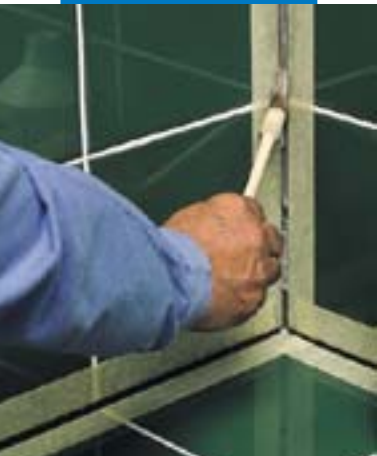
Auftragen der Grundierung Primer FD
