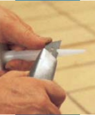
Abschneiden der Kartuschenspitze
