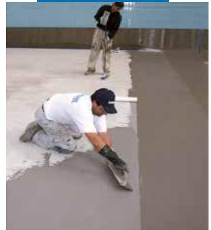
Abdichtungsarbeiten an einem Schwimmbecken mit Mapelastic
