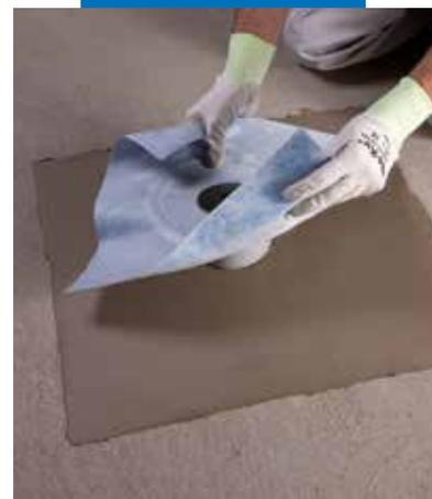
Einbau eines Ablaufs in einer Abdichtungsschicht aus Mapelastic
