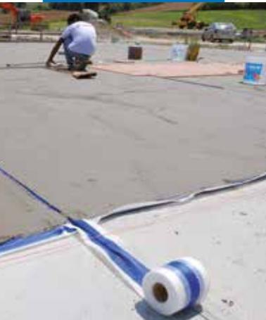
Abdichtungsarbeiten mit Mapelastic und Mapeband
