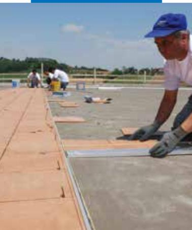
Verlegung keramischer Fliesen mit Kerabond / Kerabond T + Isolastic
